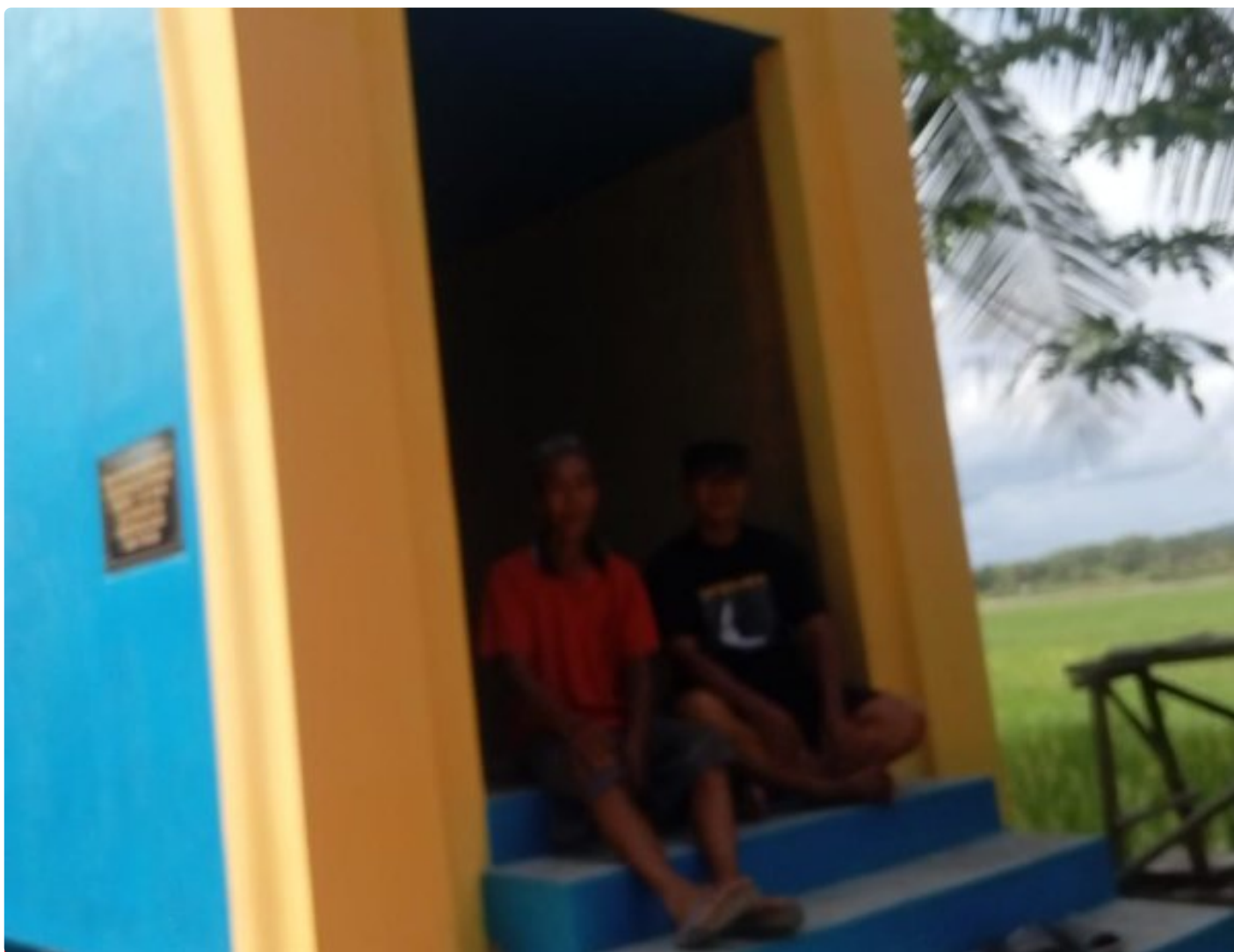
Pembangunan Irigasi Perpompaan di Desa Binangun
